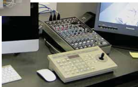
Профессиональное аудио- и видеооборудование установлено в контрольной комнате
