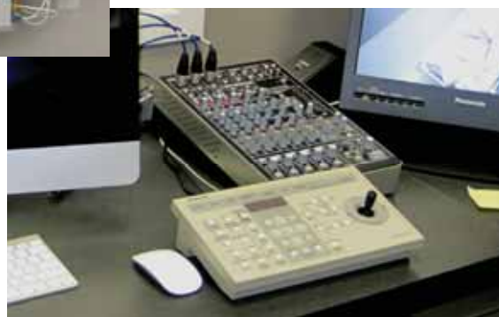
Профессиональное аудио- и видеоборудование установлено в контрольной комнате
